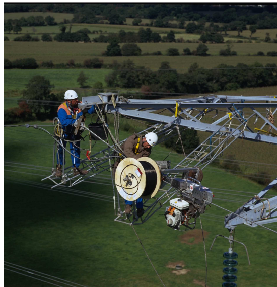
Pose de fibres optiques au moyen d'un robot spécialisé
