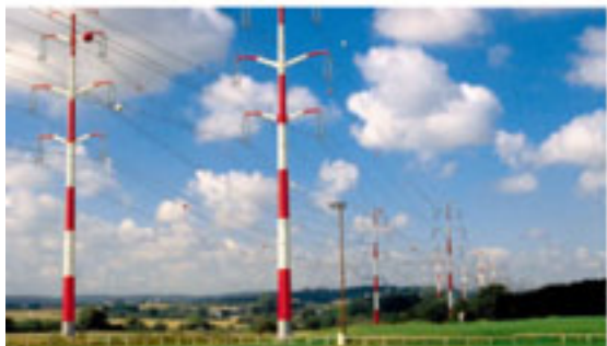
Exemple de balisage diurne de pylônes
