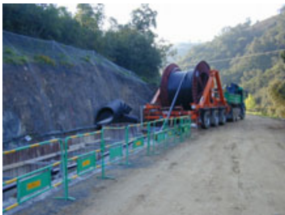
Déroulage des câbles dans les fourreaux
