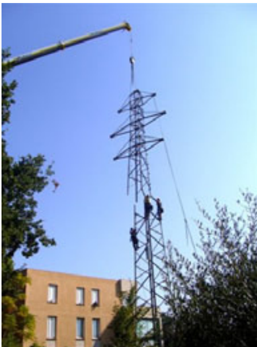
Démantèlement d'un pylône à proximité de l'habitat
