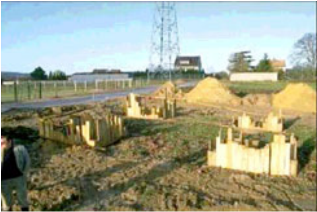
1 ère étape : Réalisation des fouilles
