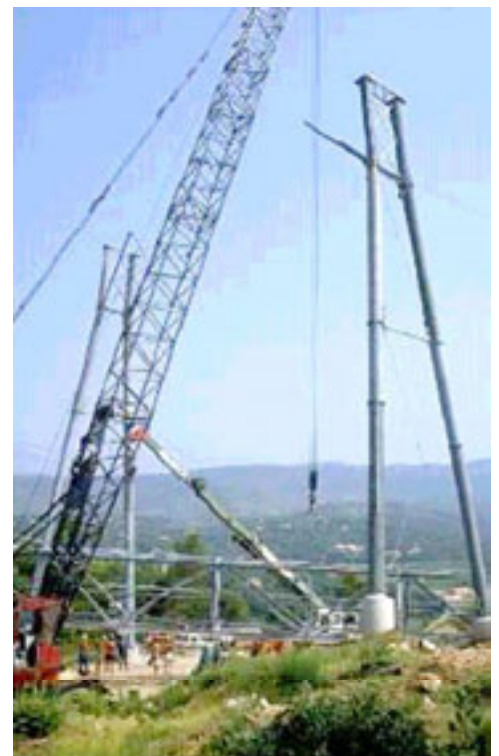
Opération de levage à la grue d'un pylône de type «portique»
