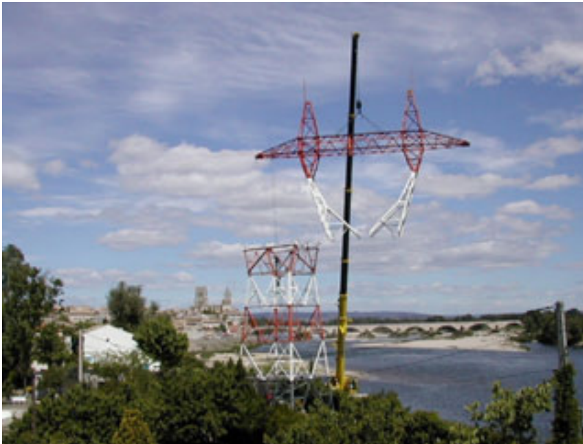
Démantèlement d'un pylône par tronçon à la grue
