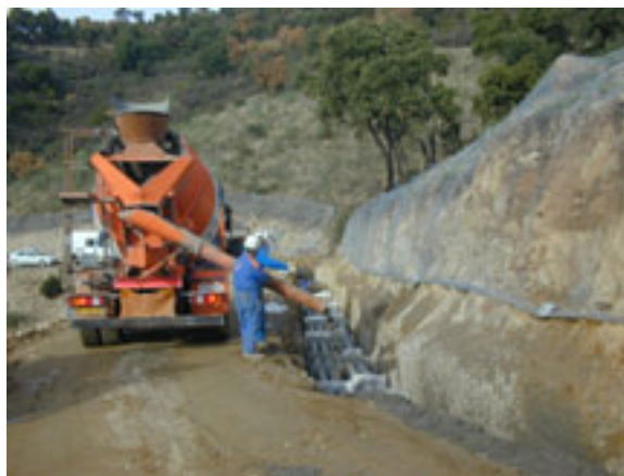
Coulage béton sur les fourreaux
