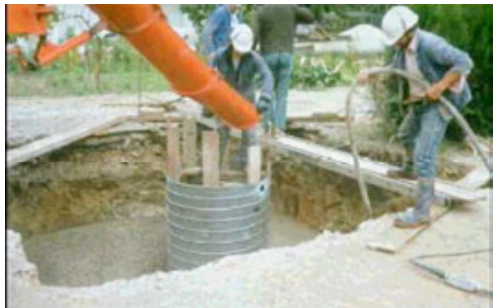
2 ème étape : Coulage du béton
