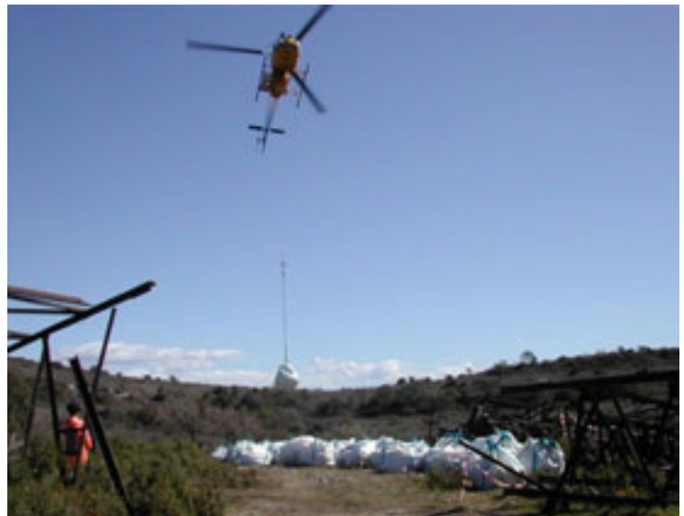
Démantèlement d'un pylône à l'hélicoptère
