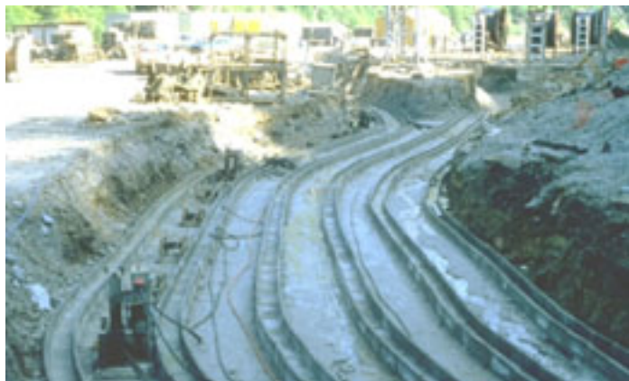
Réalisation d'une tranchée pour pose en caniveaux dans un poste
