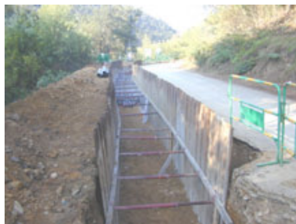
Mise en place de fourreaux d'une liaison souterraine à deux circuits
